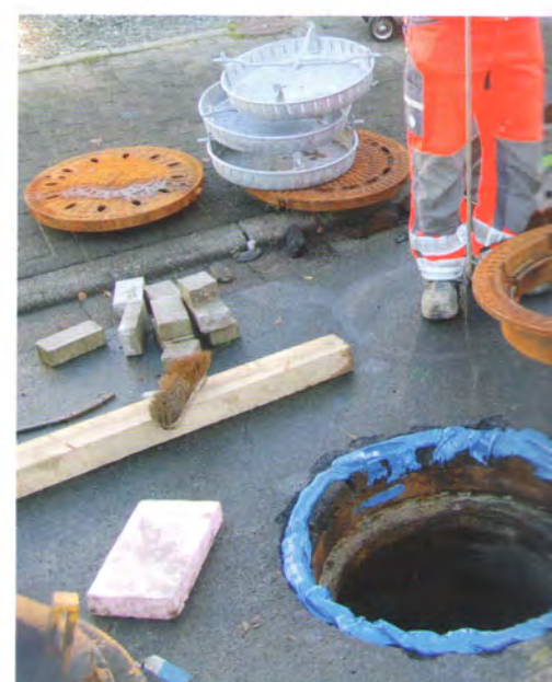
Mitarbeiter Thomas Sy trägt das Epoxidharz FlexyPox per Spritzbeutel auf den Asphalt auf.
