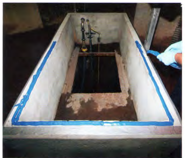
Bild 2: Harzauftrag: Der Epoxidkleber FlexyPox wird auf den Betonsockel aufgetragen
