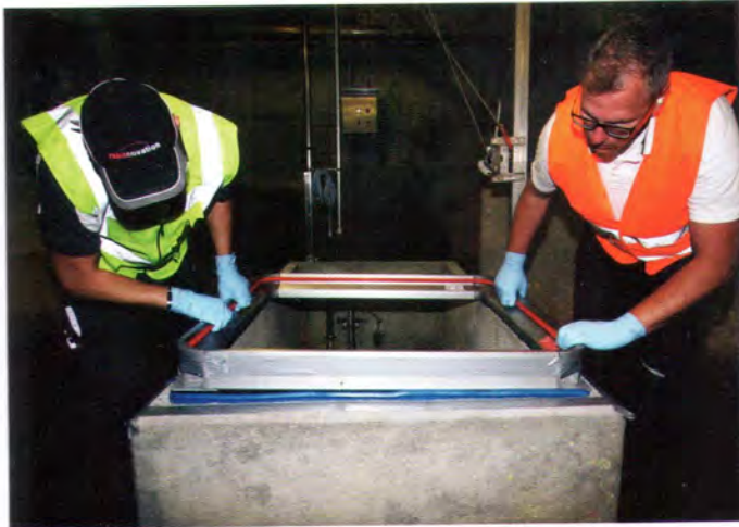
Bild 3: Alurahmen auflegen: Auf die Harzschicht wird der Alurahmen der tagwasserdichten Abdeckung gelegt
