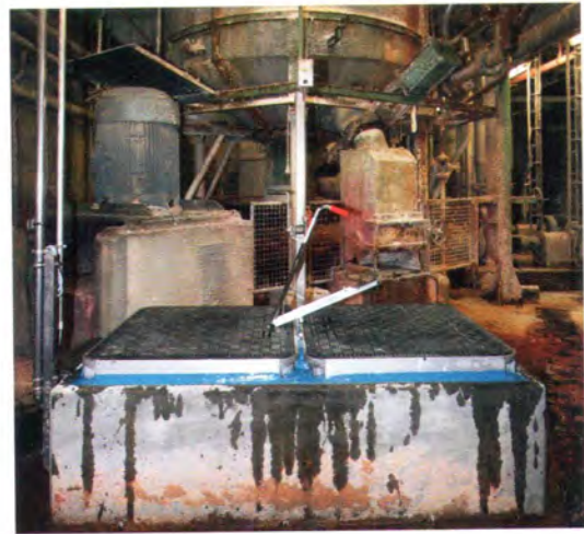
Bild 4: Fertige Faserverbundabdeckung: Die Fibre Industrial-Schachtabdeckungen aus Faserverbundstoff sind tagwasserdicht mit dem Sockel verklebt und schützen das Grundwasser vor Verunreinigungen
