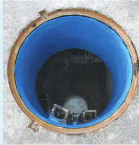
Tagwasserdichte Schachthalsbeschichtung mit FlexyPox
