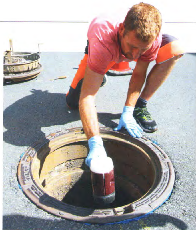
Auf Straßenniveau gehämmert: Auf das frische Harz wird die Schachtabdeckung wieder aufgelegt und vorsichtig mit dem Gummihammer eingepasst.
