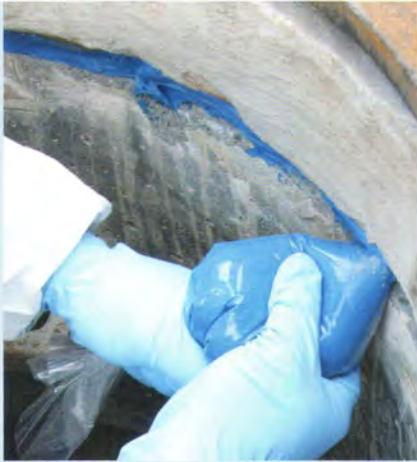
Abdichten von Fugen mit FlexyPox
