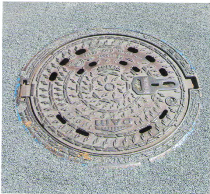
Fertig saniert: Nun liegt die Abdeckung wieder eben. | Fotos: Katja Nicklaus/resinnovation GmbH
