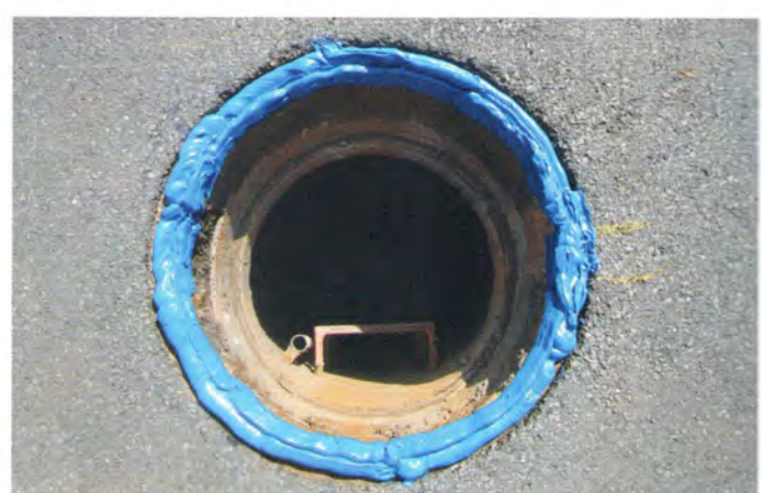
FlexyPox lässt sich per Spritzbeutel leicht und zielgenau auftragen. Ein dauerflexibler Ring aus Harz wird künftig die Verkehrslasten abfangen.
