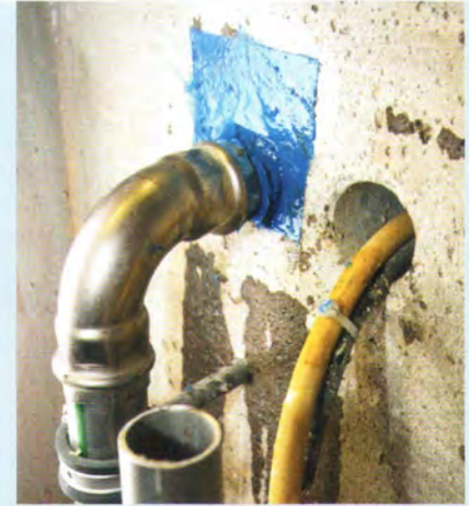
Abgedichtete Rohrdurchführung
