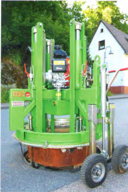
Mit dem Schachtrahmenheber der Strabag GmbH (Bad Hersfeld) wird der Rahmen der Abdeckung herausgehoben.
