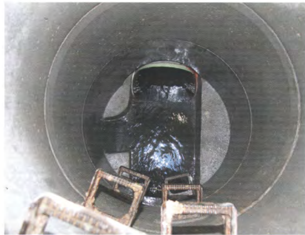
Bild 4: „Liner“-Überstand nach Verlängerung mit PARTLINER™, hier der Ablauf
