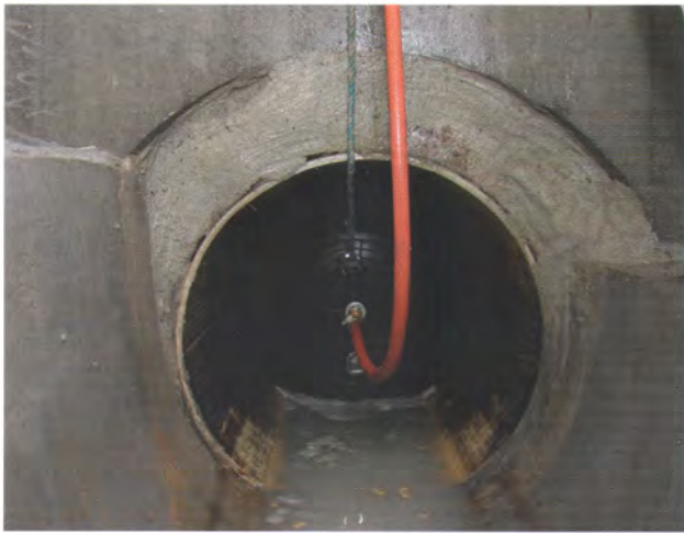
Bild 3: Zulauf nach der Reprofilierung
