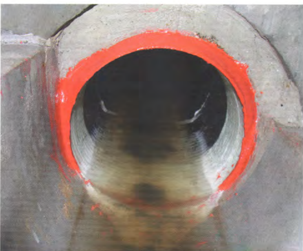
Bild 5: Fertige Anbindung des Zulaufs mit PARTLINER™ und Harz8
