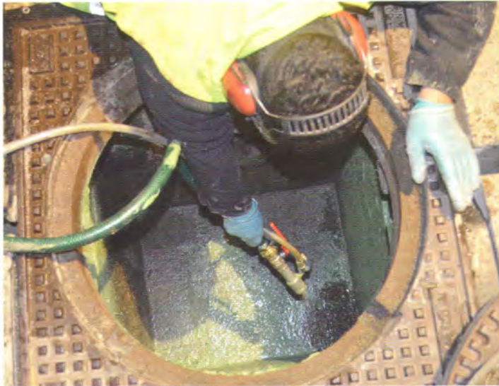
Bild 3: Das resiShield LV wird im Sprühverfahren in den Schacht aufgebracht
