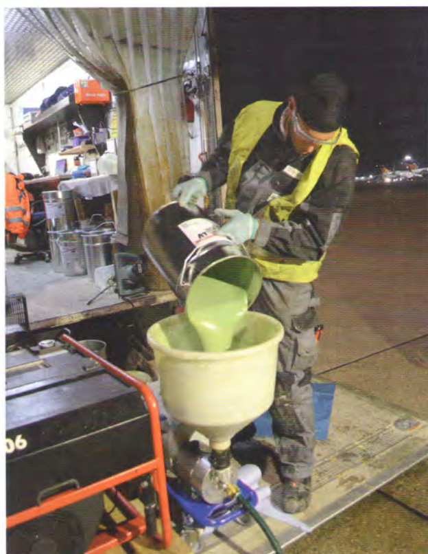
Bild 1: Einfüllen des resiShield LV-Harzes in eine Peristaltikpumpe
