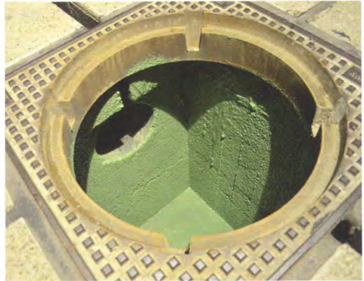
Bild 4: Fertig beschichteter Schacht
