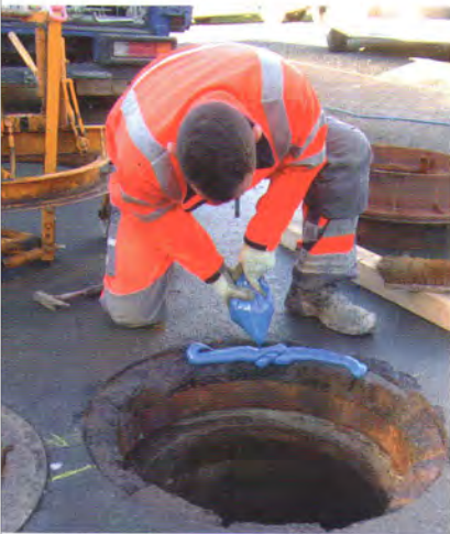
Bild 3: Thomas Sy trägt das Epoxidharz FlexyPox per Spritzbeutel auf den Asphalt auf
