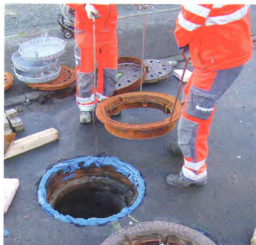
Bild 4: Mit den Schachthaken wird die Schachtabdeckung passgenau auf das Epoxidharz aufgesetzt
