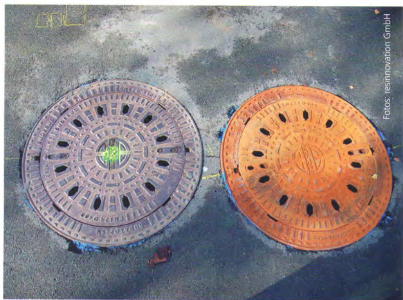
Bild 6: Die beiden sanierten Schachtabdeckungen trotzen nun wieder der Verkehrsbelastung - dank FlexyPox auf Deckenniveau und damit ohne Lärmmission
