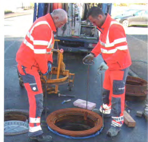
Bild 5: Mit Schachthaken passen Dieter Pfeil (l.) und Thomas Sy die Schachtabdeckung sorgfältig in die mit Epoxidharz vorbereitete Öffnung ein
