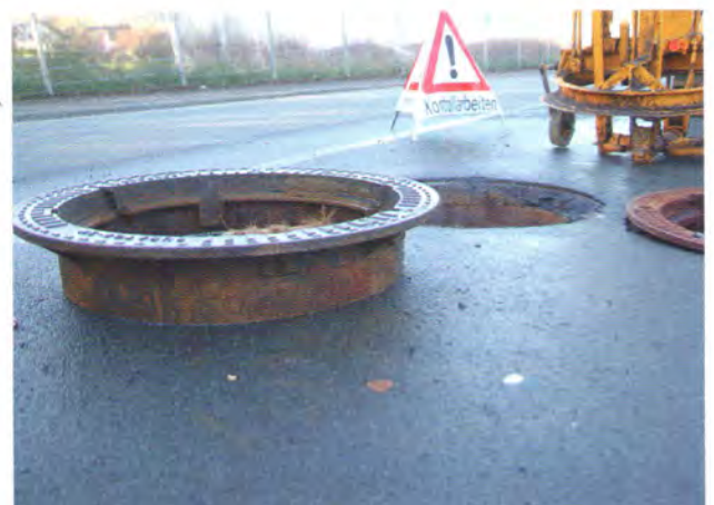
Bild 2: Die schwimmenden Schachtabdeckungen liegen nicht auf dem Schachtrahmen auf, sondern übertragen die Verkehrslasten über einen breiten Rahmen auf den Oberbau der Straße
