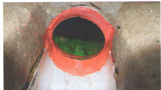
Bild 3: Die fertige Ringspaltabdichtung mit Harz8 hat eine kleinen Rampe aus Harz, damit das Abwasser hindernisfrei ablaufen kann
