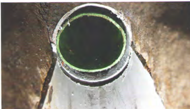
Bild 2: Der für die Ringspaltabdichtung vorbereitete Abfluss mit Einschnitt im Sohlbereich
