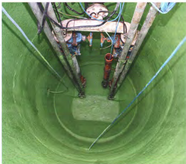
Bild 2: Saniertes Pumpwerk mit grüner Schutzschicht
