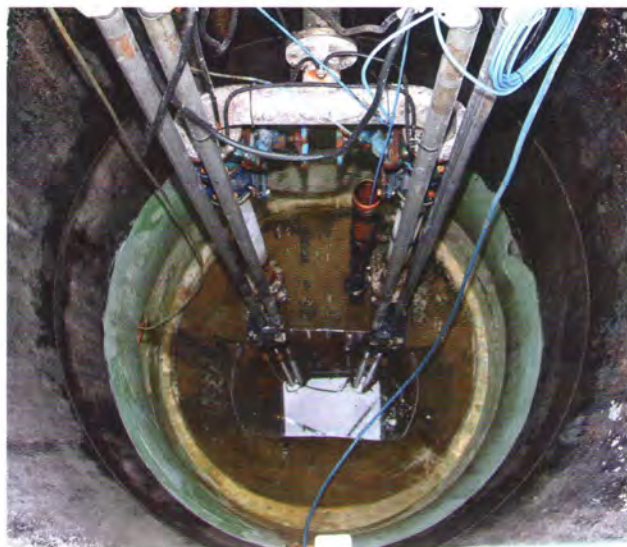
Bild 1: Pumpwerk vor der Sanierung
