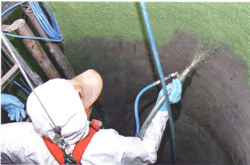
Bild 3: Alles wird grün - Aufbringen der Beschichtung mit Sprühtechnik
