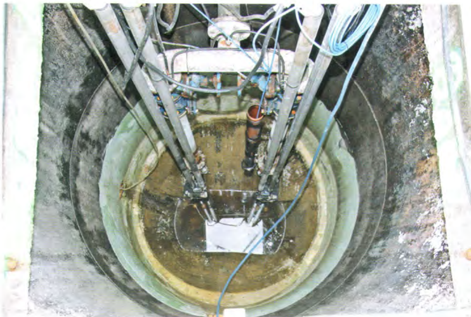
Pumpwerk vor der Sanierung
