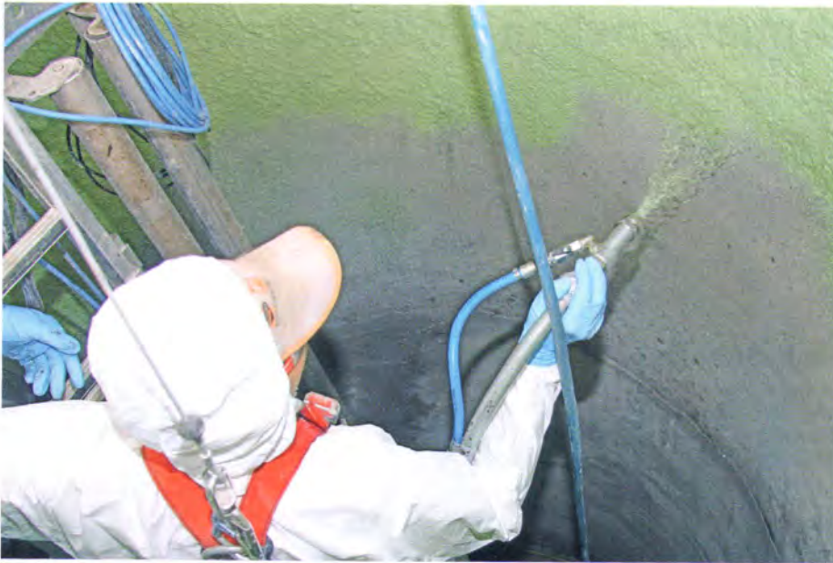
Nach der Reinigung und Reprofilierung wurde das Epoxidharz resiShield auf die Schachtwand gesprüht.
