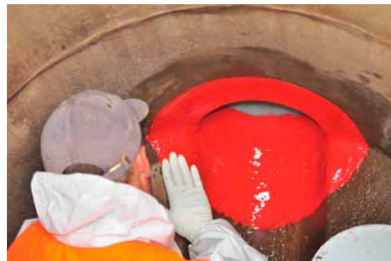
Einfache, aber gründliche Verarbeitung: Das Spachtelharz wird aus einer Spritzdüse heraus appliziert und dann manuell sorgfältig eingearbeitet.
