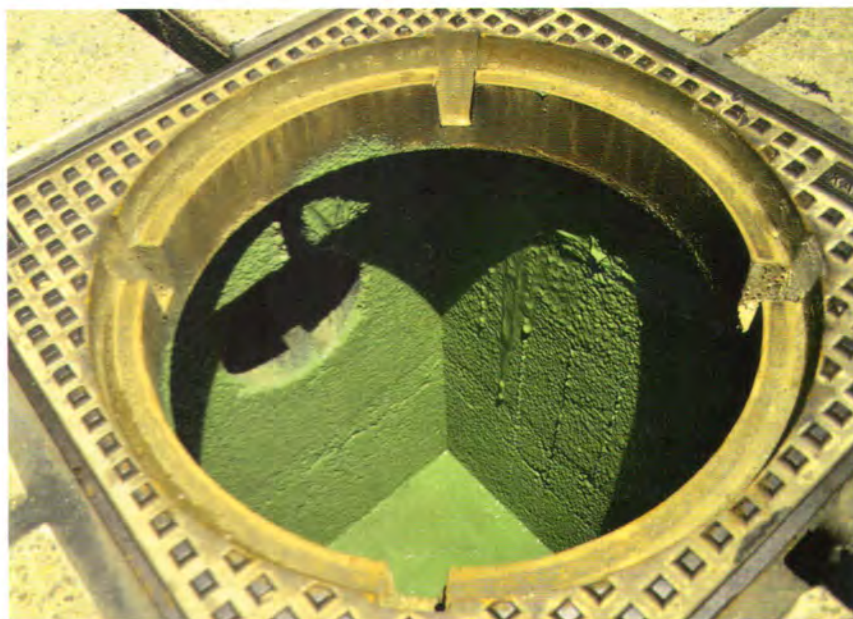
Beschichteter Schacht nach Abschluss der Ertüchtigungsmaßnahmen
