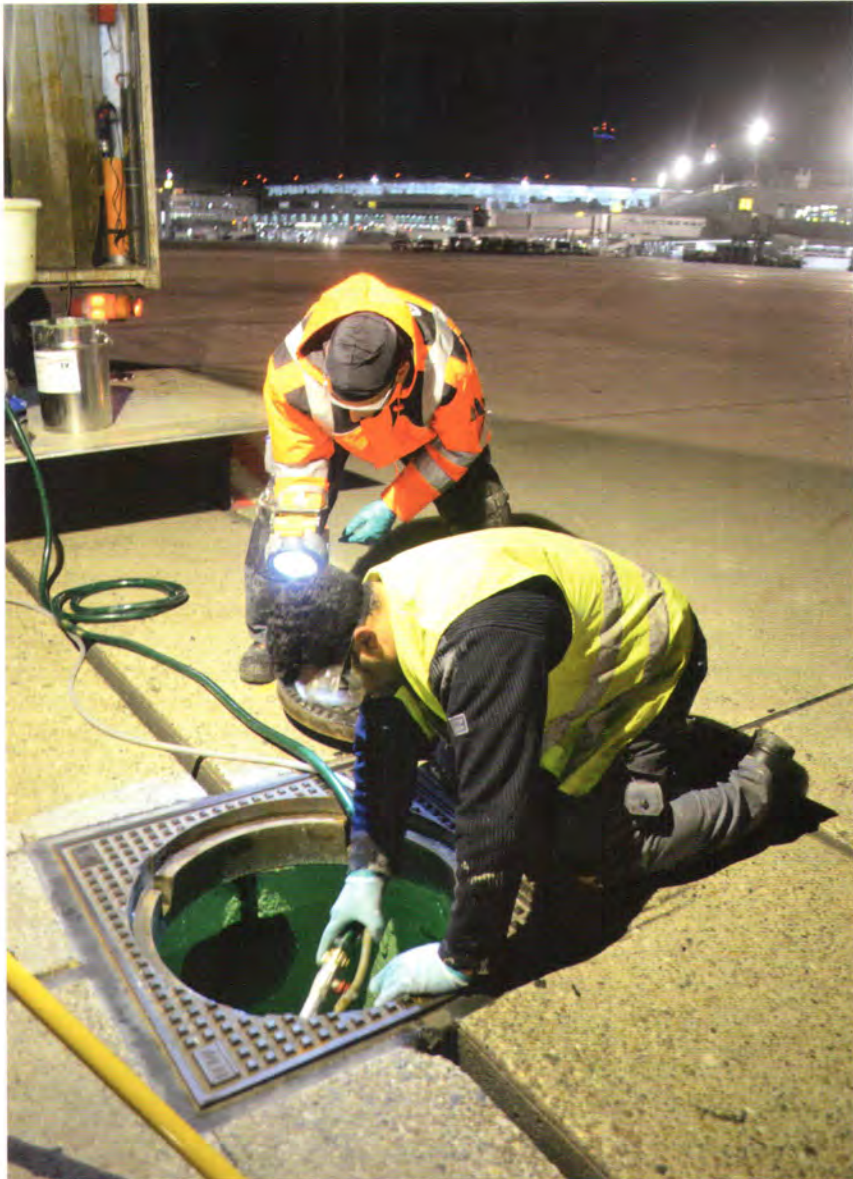
Schachtbeschichtung auf dem Vorfeld des Flughafen Düsseldorf
