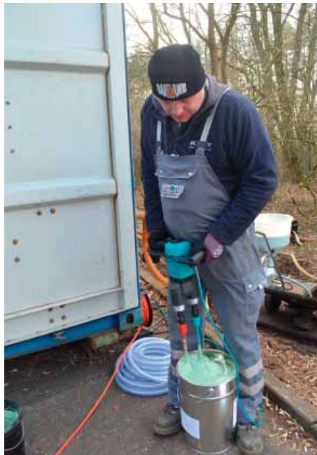
Schon besser: 2-Wellen-Mischgerät mit Beidhand-Griff. Die Emissionen des offenen Eimers bleiben jedoch ein Problem. Bei zu hoher Drehzahl kann Luft ins Harz eingetragen werden.
