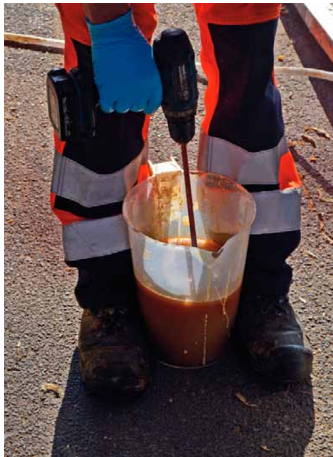
Häufiger Anblick auf deutschen Sanierungsbaustellen: Handmischer mit einer Rührwelle. Die gebückte Körperhaltung führt zu erhöhter Schadstoff-Exposition des Mitarbeiters.
