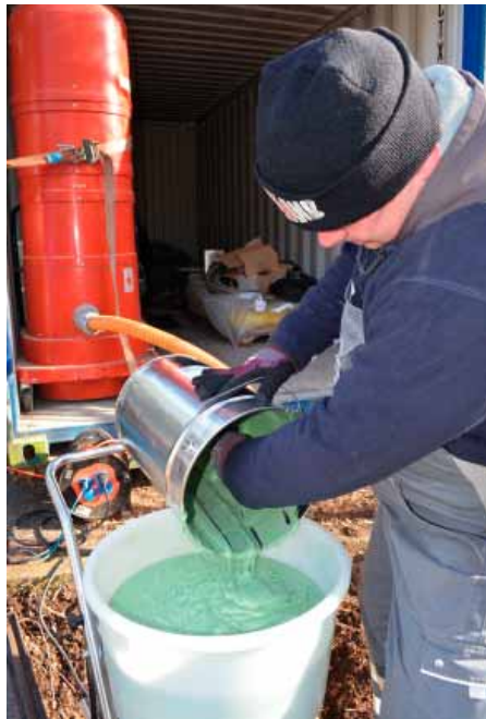
Kernproblem: Restmengen und Gebinde-Abfall
