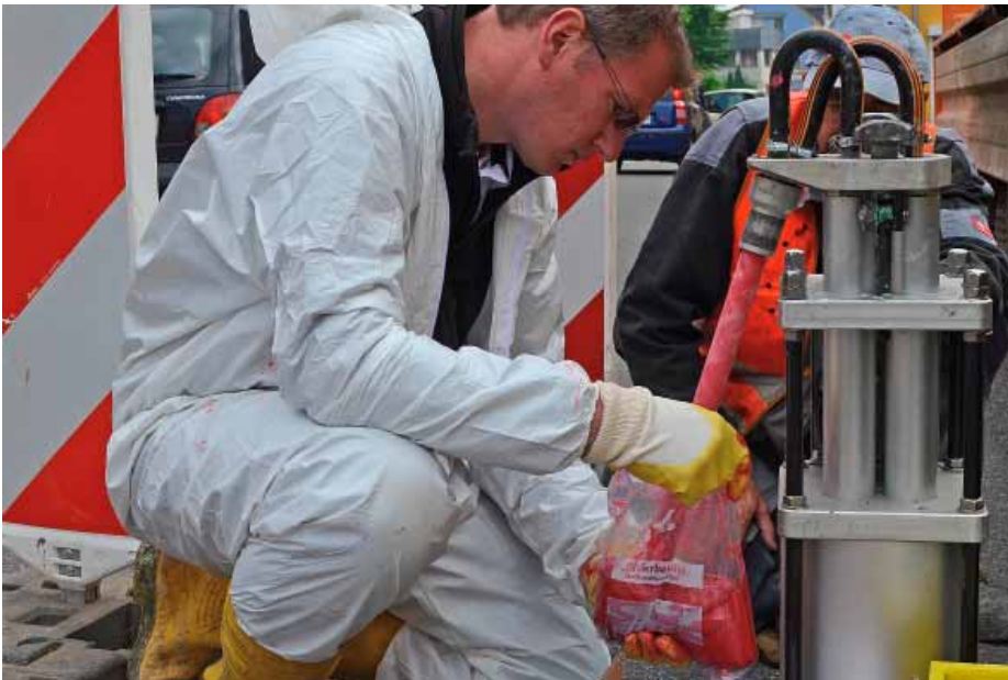
Abfüllen aus dem Statikmischer in eine Spritztüle...
