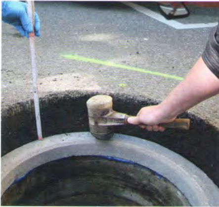
Setzen des neuen Schachtrings
