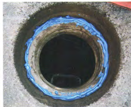
Nach dem Entfernen des defekten Schachtrings und der Reinigung wurde das blaue Epoxidharz FlexyPox aufgetragen, das die Grundlage für den neuen Schachtring bietet.
