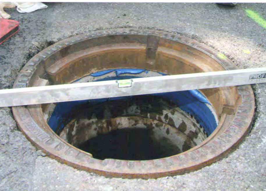
Die Schachtabdeckung ist wieder auf der gleichen Höhe wie die Fahrbahn.
