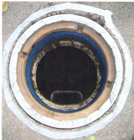
Abkleben für Spaltverfüllung
