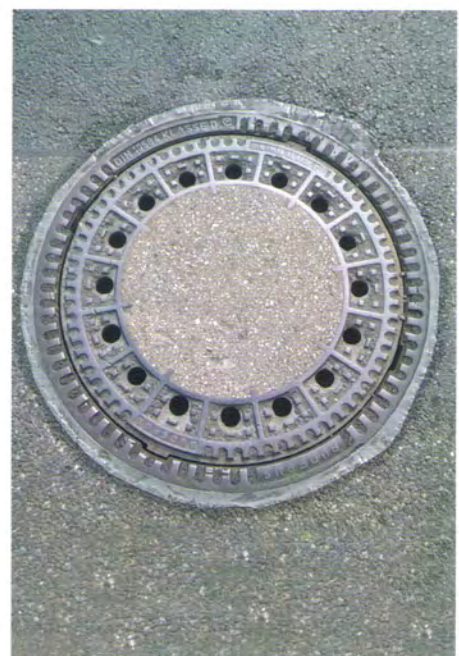
Sanierte Schachtabdeckung
