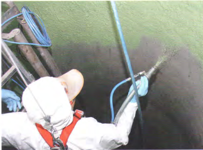
In nur 30 Minuten beschichtete das Team rund 40 m 2 Schachtwand im Sprühverfahren mit dem Epoxidharz
