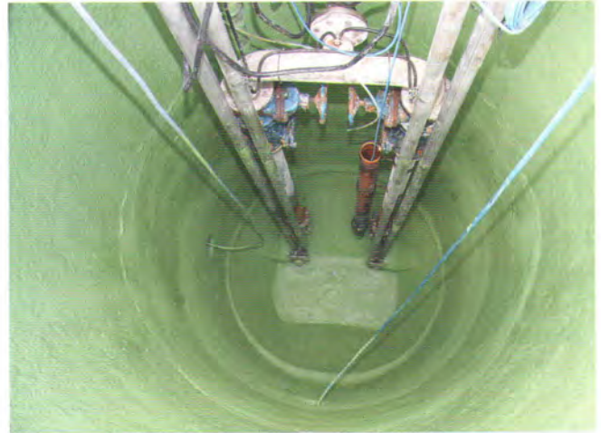
Nach der Sanierung ist das Pumpenwerk gegen Brauerei-Abwässer geschützt
