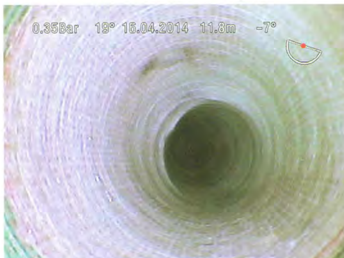
Bild 1. PARTLINER™: erster Kurzliner auf Epoxidharzbasis mit allgemeiner bauamtlicher Zulassung
