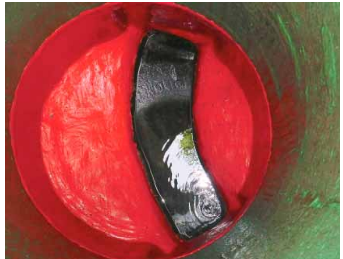
Rot-grüne Epoxid-Kombination: Schachtwand-Beschichtung mit resiShield, Sohlaukleidung mit Harz8.
