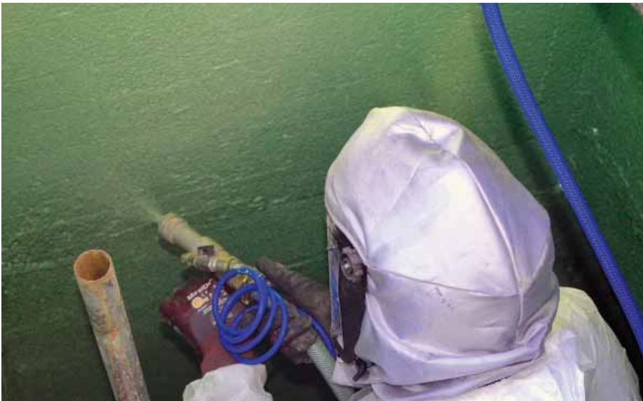
In Sprühtechnik lassen sich große Flächen schnell und gleichmäßig mit resiShield beschichten.
