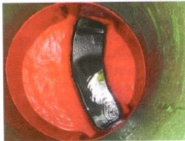
Rot-grüne Epoxid-Kombination: Schachtwand-Beschichtung mit resi-Shield, Sohl-auskleidung mit Harz8.
