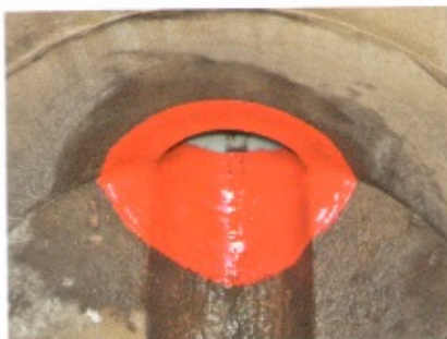
Schlauchliner-Schachteinbindungen mit Harz8 RP 20 sind eine echte Dauerlösung – auch da, wo Liner und/oder Schacht dauerhaft Erschütterungen ausgesetzt sind.
