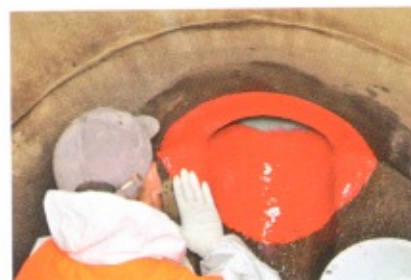
Einfache Verarbeitung: Das Spachtelharz wird aus einer Spritzdüse heraus manuell appliziert.
