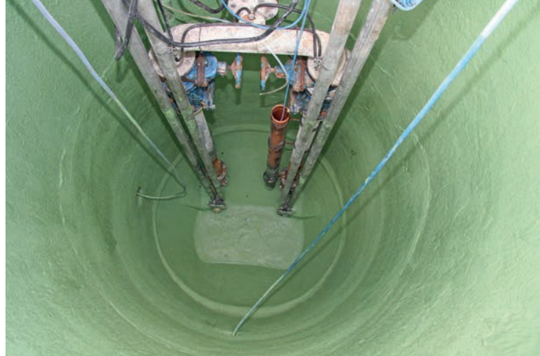
Nachher: In frischem Grün stellt sich das Pumpwerk nach der Sanierung künftig den täglichen Herausforderungen.
