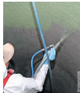
Auftrag ResiShield: In 30 Minuten wurden rund 40 m 2 Schachtwand im Sprühverfahren beschichtet.
