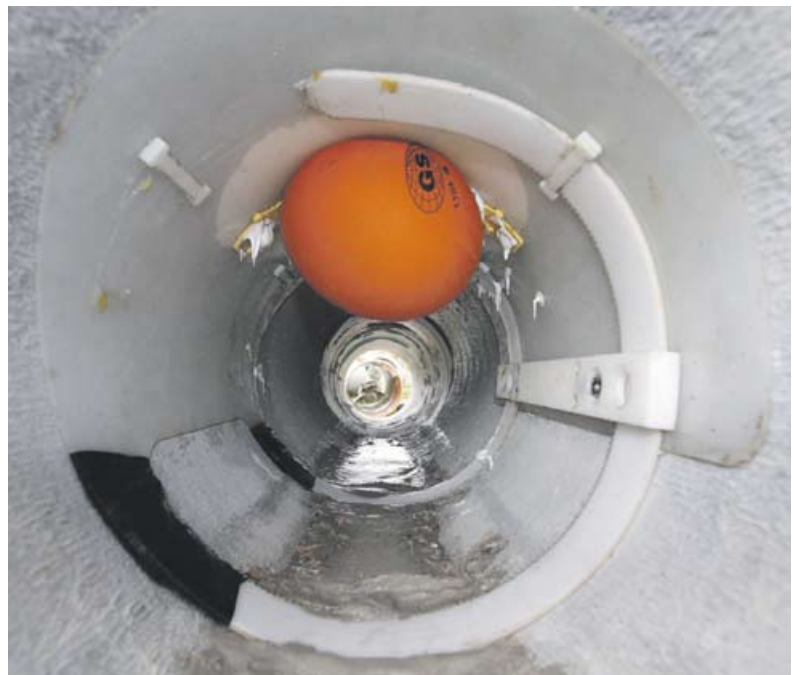
Harz14 beim Aushärten: Beim KATE-System bleibt dabei nur die Verschalung an Ort und Stelle. Mit dem Roboter wird woanders weitergearbeitet.
