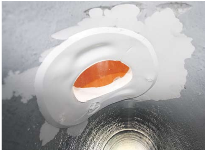
Fertiger Stutzen mit Harz14 – verpresst mit dem Hächler-Roboter.
