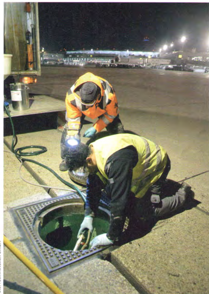
Schachtbeschichtung auf dem Flughafen Düsseldorf.
