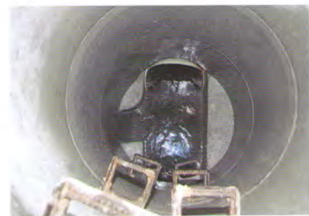
Liner-Überstand nach Verlängerung mit Partliner – hier der Ablauf.
