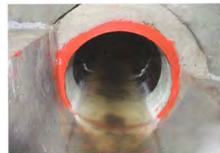
Fertige Anbindung des Zulaufs mit Partliner und Harz8.
