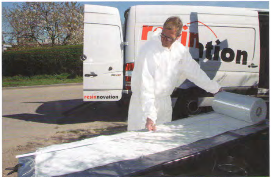
Dino Heuser, resinnovation-Geschäftsführer, beim Zuschnitt der Glasfaser-matte für den Partliner.
