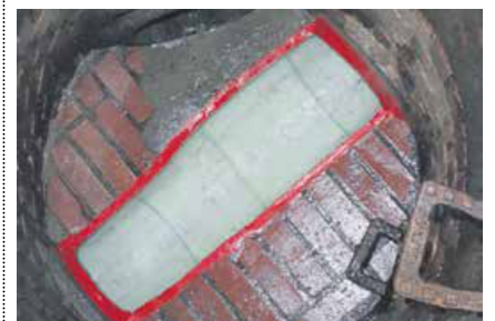
Gerinneliner im gemauerten Schacht: Das neue Verfahren passt sich allen Geometrien und Gegebenheiten an.
