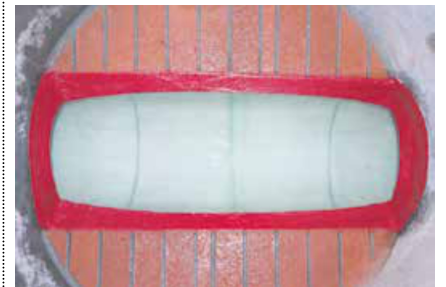
Gerinneliner im Klinkerschacht.
