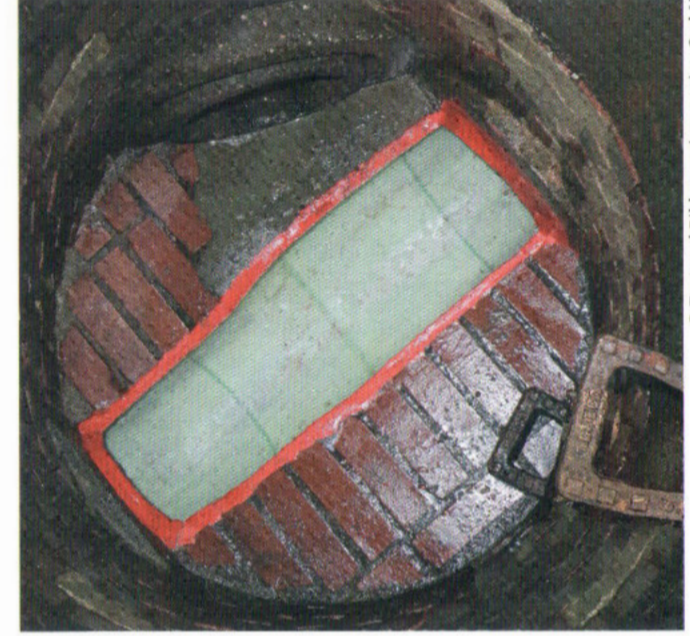
Bild 3: Der fertige Gerinneliner: Harz8 bindet das neue Gerinne dicht an den Schacht an
