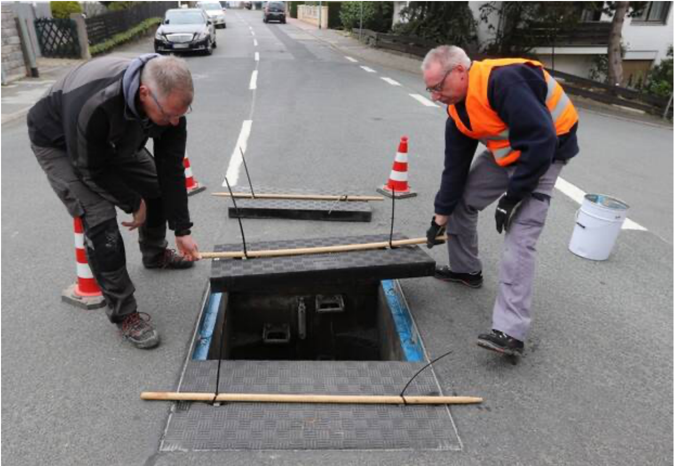
Im letzten Sanierungsschritt wird die FibreIndustrial-Abdeckung eingesetzt. Foto: resinovation GmbH
