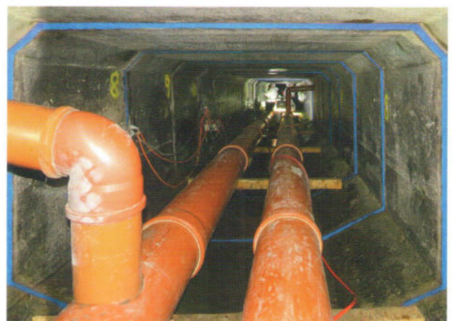
Bild 2: FlexyPox dichtet Fugen ab
