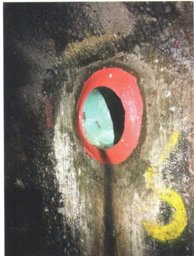
Bild 4: Hausanschluss mit Liner und Harz
