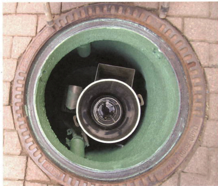
Ölabscheider mit resiShield saniert | Fotos: Resinnovation
