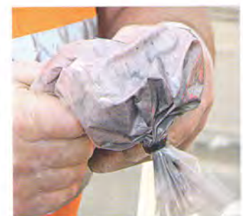
Mischen im Beutel: Das »manuelle« Durchkneten ist eine beliebte Technik für pastöse Kunstharze.
