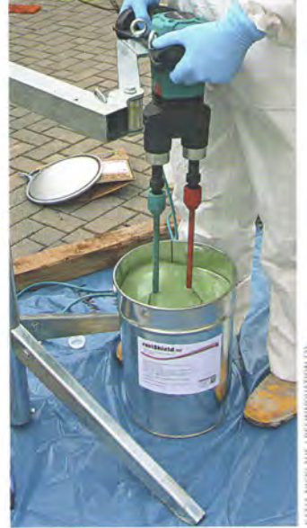
Doppelrührwerke eignen sich für bestimmte Baustoffe – eine Standvorrichtung beugt der Ermüdung der Arme vor, um die Mindestmischzeit einzuhalten.
