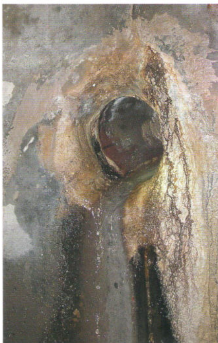
Hausanschlüsse wurden per Schlauchliner saniert, die Anbindungen mit dem ebenfalls dauerflexiblen Harz8 abgedichtet. | Fotos: resinovation
