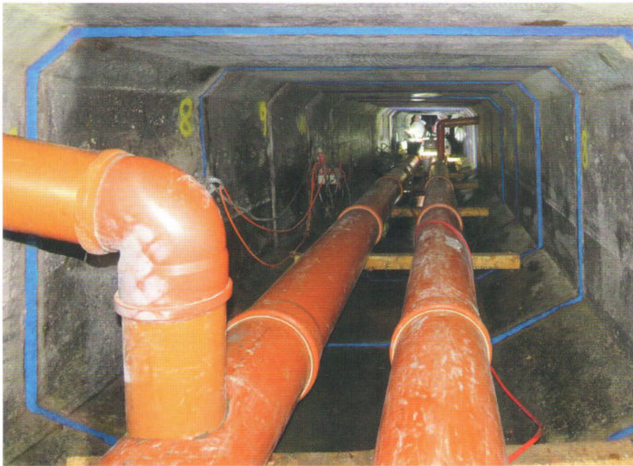
Wie blaue Adern durchziehen die mit FlexyPox abgedichteten Fugen den Sammler. Das dauerelastische Epoxidharz dichtet zuverlässig ab und härtet schnell und rissfrei aus.
