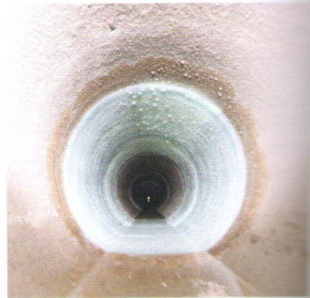
Imprägnierter, kalibrierter und eingebauter Partliner im Kanal | Fotos: resinnovation
