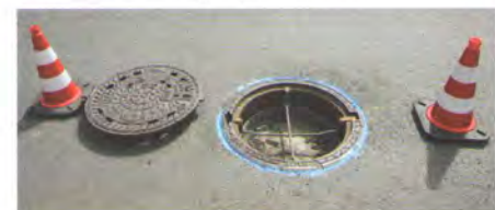
Abb. 5: Die Abdeckung liegt wieder eben
