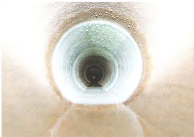
Bild 5. Ergebnis: PARTLINER im Kanal
