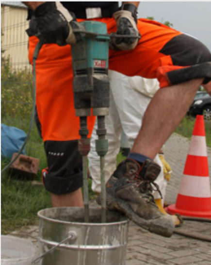
Bild 5: Doppelrührer mit Mörtel
