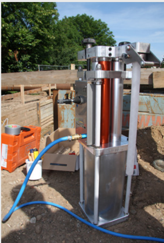
Bild 10: 4K-Pastenmischanlage 1.0 auf der Baustelle
