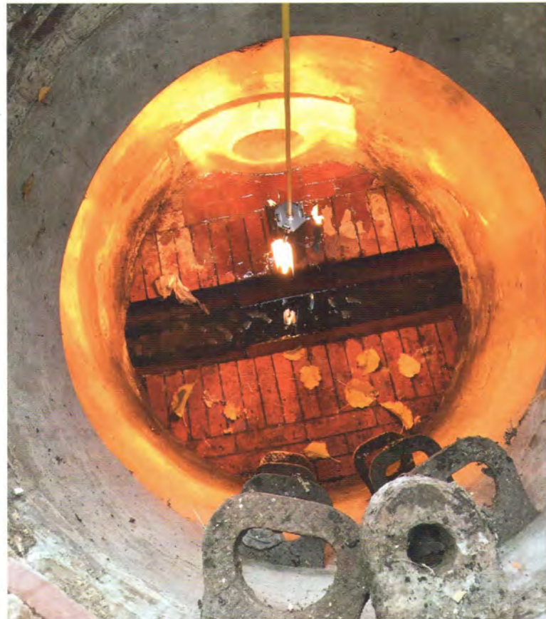
Der Schachtheizer begünstigt die Vernetzung des Epoxidharzes und verkürzt auch beim Handlaminat mit resiGRP die Abbindezeit deutlich
