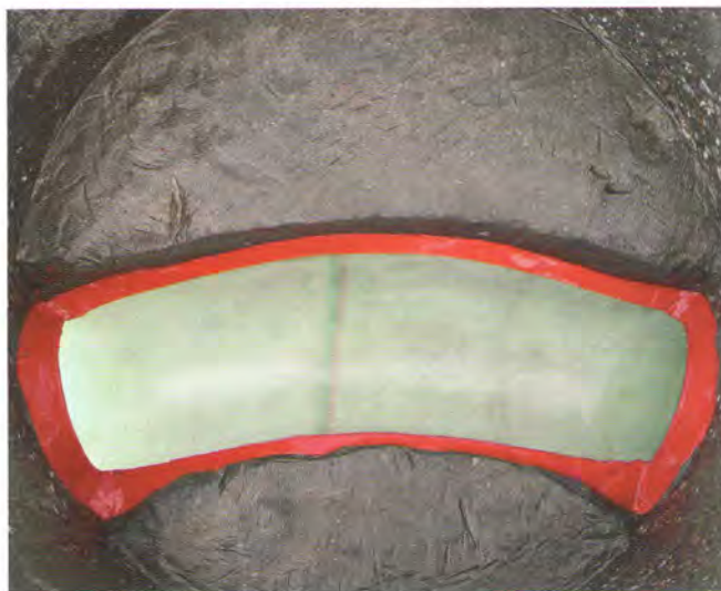
Perfekte Verbindung von PARTLINER™ und Harz8: Der Gerinneliner ist variabel einsetzbar in unterschiedlichen Geometrien oder auf unterschiedlichen Materialien
