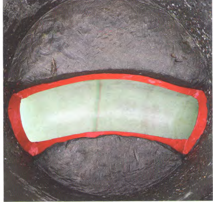
Gerinneliner im geklinkerten Schacht/Gerinneliner in Betonschacht: Perfekte Verbindung von PARTLINER™ und Harz8: Der Gerinneliner ist variabel einsetzbar in unterschiedlichen Geometrien oder auf unterschiedlichen Materialien.
