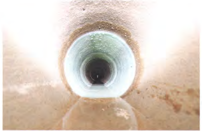
App-gesteuert perfekt gemischter, imprägnierter, kalibrierter und eingebauter PARTLINER™ im Kanal.
