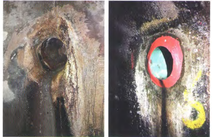
Ausgangslage Hausanschluss
