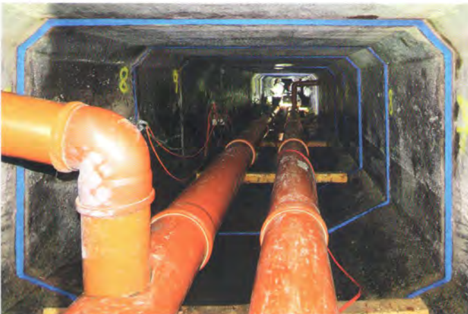
FlexyPox dichtet Fugen ab
