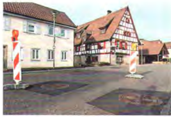
Das Bild nach der Sanierung.
