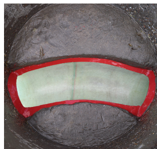
Gerinneliner im Betonschacht
