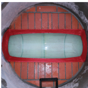
Gerinneliner im Klinkerschacht
