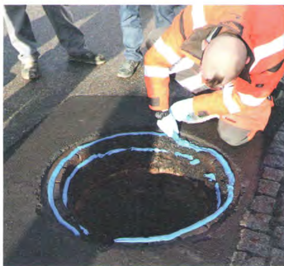
FlexyPox wird aufgetragen.
